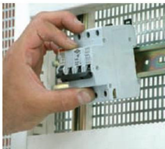
طرز قرارگیری فیوز روی ریل
