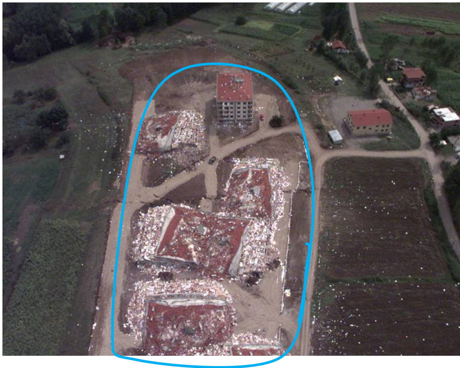
تصویر ۶: تصویر مربوط به زلزله ۱۹۹۹ از میر ترکیه، (۱۳۷۸ ه.ش) با بزرگای ۷/۴ در مقیاس ریشتر، در محدوده مشخص شده پنج ساختمان وجود دارد که فقط یک ساختمان (با توجه به طراحی و اجرای درست) ریزش نکرده و تمامی طبقات آن سالم است
