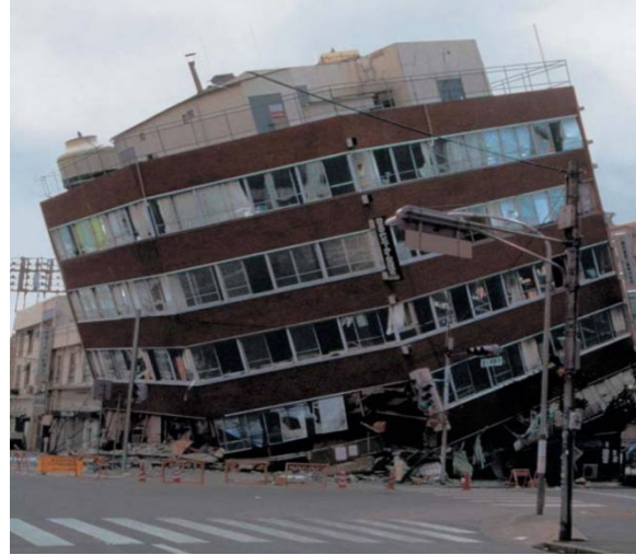
تصاویر ۴ و ۵: تصاویر مربوط به زلزله ۱۹۹۵ کوبه ژاپن، (۱۳۷۳ ه.ش) با بزرگای ۶/۸ در مقیاس ریشتر، این ساختمان‌ها به دلیل ضعف در طراحی و اجرا دچار آسیب شده‌اند.
