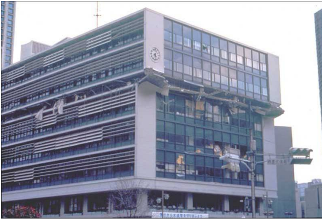
تصاویر ۴ و ۵: تصاویر مربوط به زلزله ۱۹۹۵ کوبه ژاپن، (۱۳۷۳ ه.ش) با بزرگای ۶/۸ در مقیاس ریشتر، این ساختمان‌ها به دلیل ضعف در طراحی و اجرا دچار آسیب شده‌اند.
