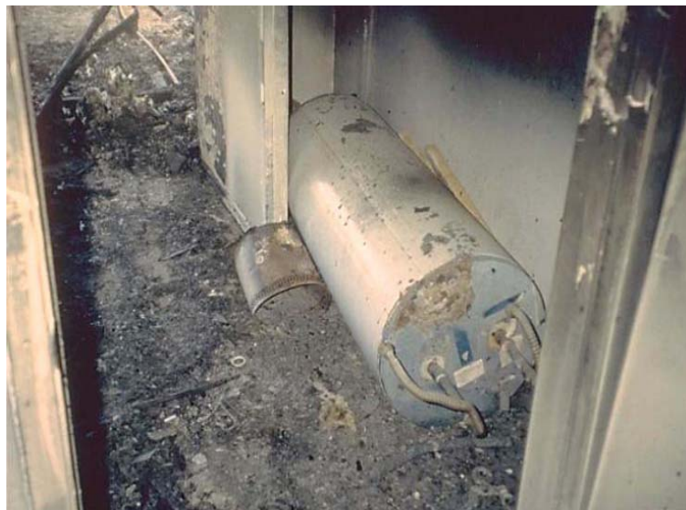
تصویر ۹: نمونه‌هایی از آسیب به اجزای غیرسازه‌ای در اثر زلزله
