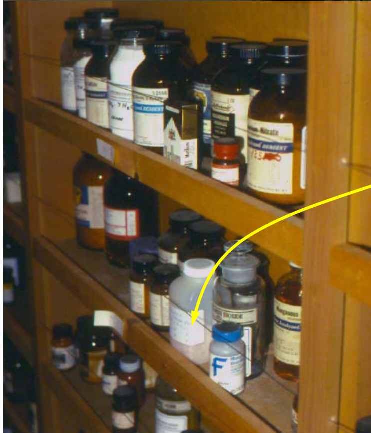
تصویر ۱۱: نمونه‌هایی از ایمن‌سازی قفسه‌ها در برابر زلزله
