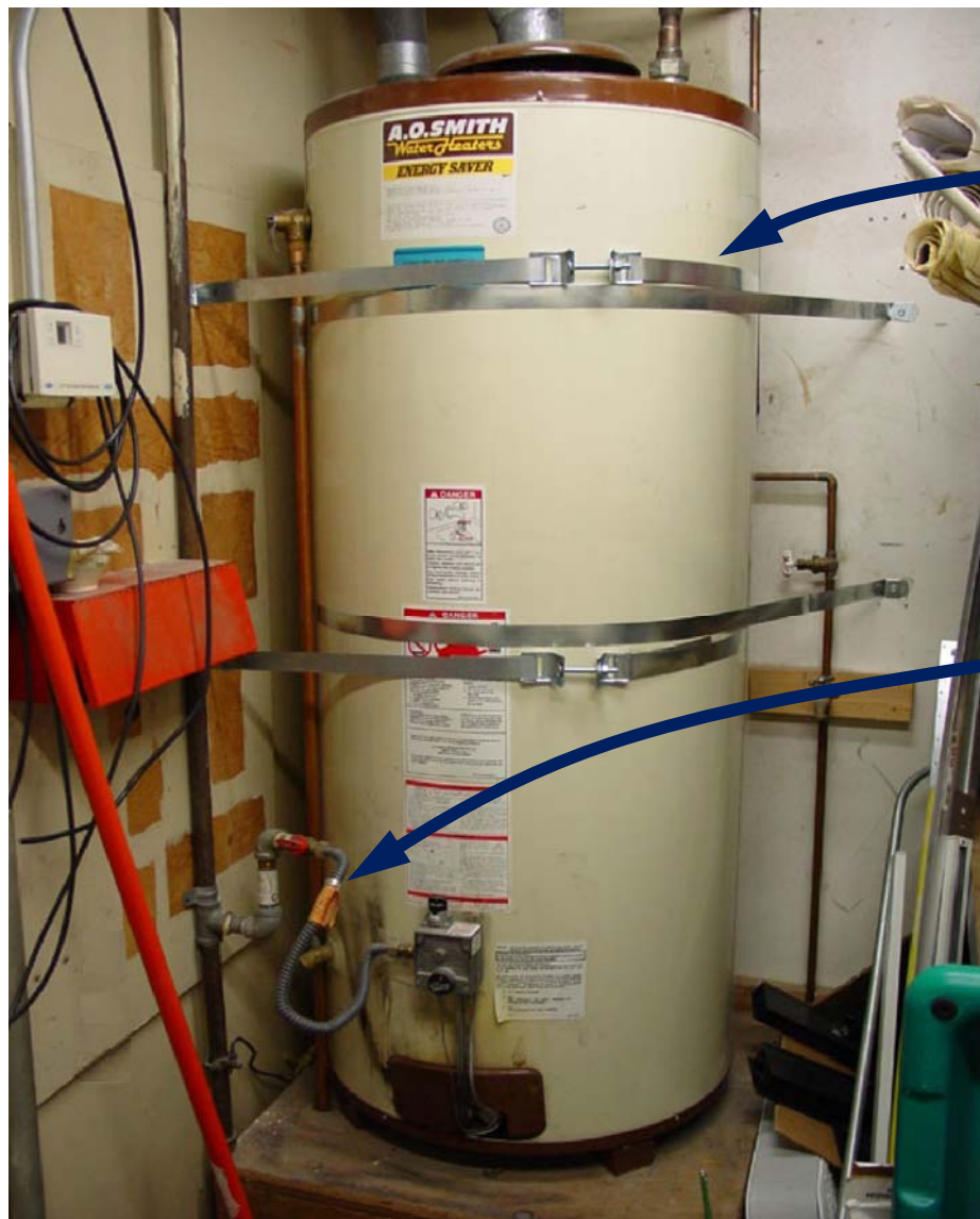
تصویر ۱۰: نمونه‌ای از نحوه مقاوم‌سازی آبگرمکن
