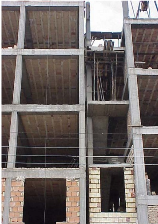
تصویر ۳: ساختمان بتنی
