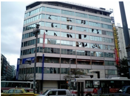
تصویر ۲۲: نمونه ای از خطر آفرینی ساختمان های با نمای شیشه ای
