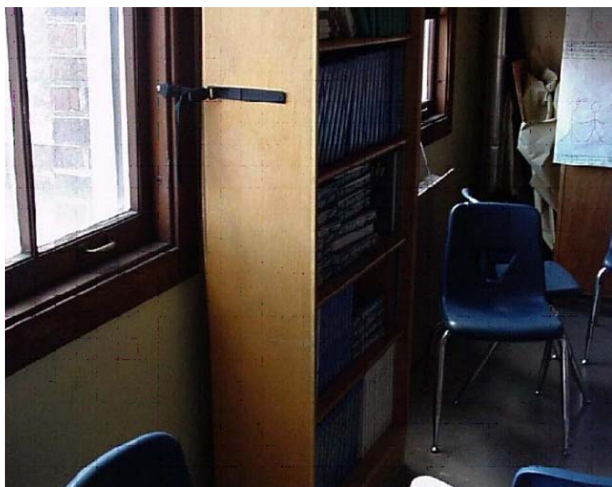
تصویر ۱۲: نمونه‌هایی از نحوه مقاوم‌سازی کمد‌ها، قفسه‌ها
