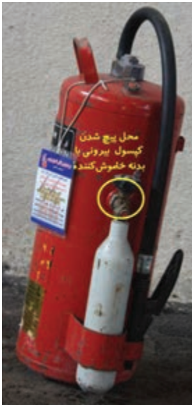
شکل ۵-۳- خاموش کننده دستی حاوی پودر و گاز فشنگ بیرون
