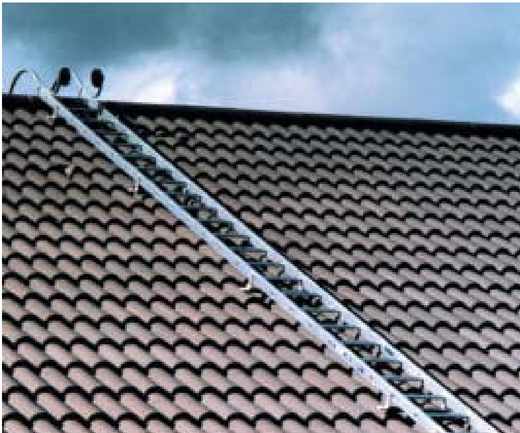
شکل های ۱-۳ نردبان سقفی ، نحوه استقرار
